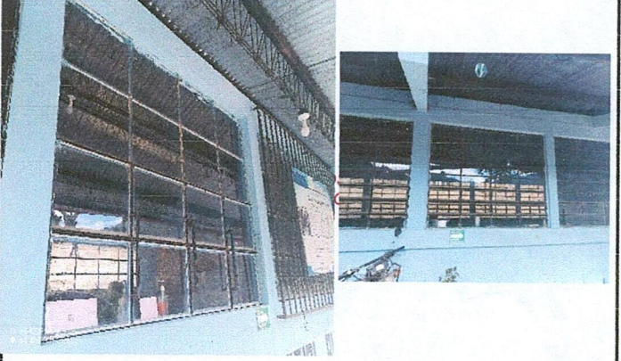
Foto 4: Mejoramiento de barandas.
