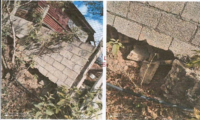
Foto 3: Mejoramiento de reparación de muro perimetral.
