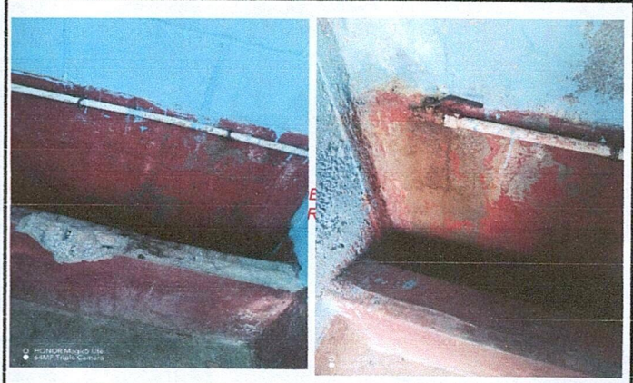
Foto 2: Mejoramiento de servicios sanitarios y sus accesorios
